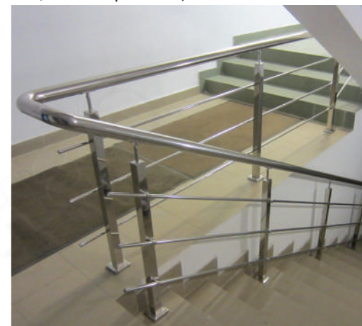
Ограждение лестницы и площадки со стойками k743, тремя ригелями и поручнем Ø50,8мм из нержавеющей стали.
