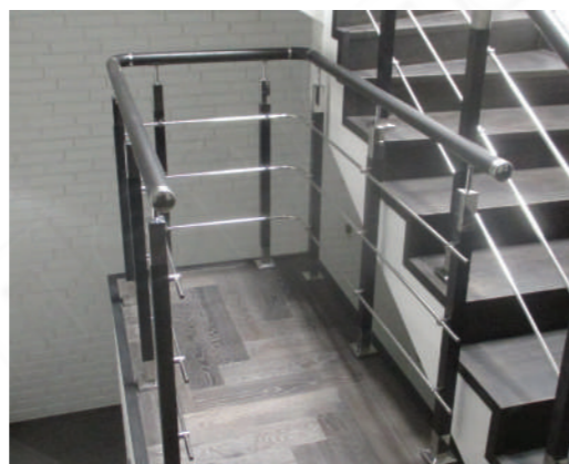
Ограждения со стойками k740-1. Вставки и поручень и дуба тонированы в черный цвет.
