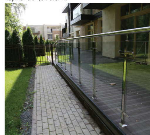
Ограждение террасы со стойками k749, прозрачным стеклом 10 мм и поручнем Ø50,8мм из нержавеющей стали.
