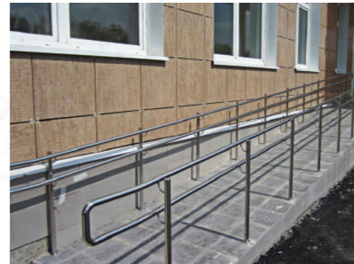
Ограждение пандуса поликлиники со стойками k750 и двойным поручнем \varnothing 38 мм из нержавеющей стали.
